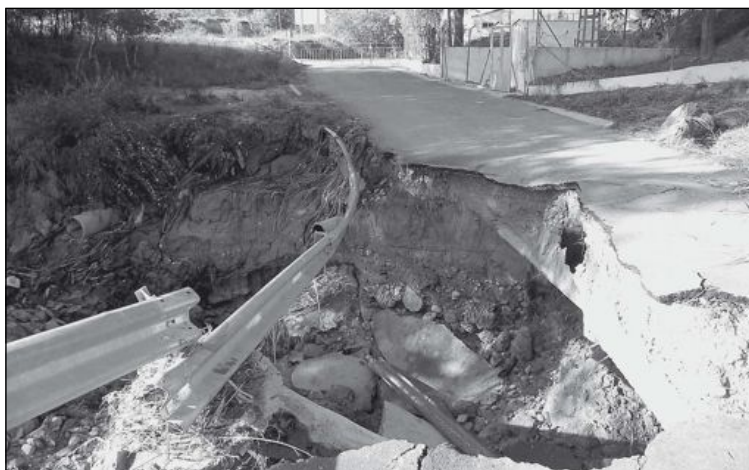
Estado en que quedó el puente de la Depuradora tras las lluvias de septiembre
