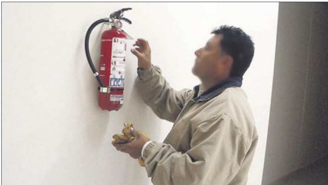
Un técnico autorizado comprueba el estado de un extintor durante la inspección anual
