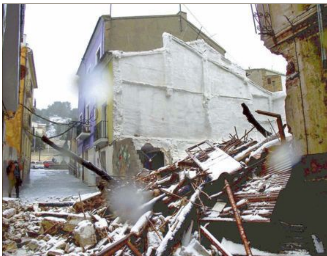
En el carrer Empedrat, las filtraciones de agua provocaron el derrumbe de una casa antigua deshabitada
