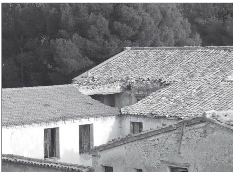
Parte de techo de la segunda planta se ha derrumbado
