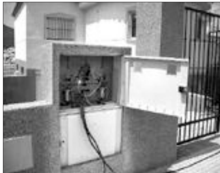
Una caseta de la luz con empalmes irregulares en Castalla Internacional
