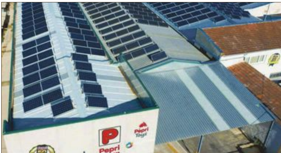
Se han instalado 391 paneles solares de 285 vatios con una potencia total de 111,44 kWp
