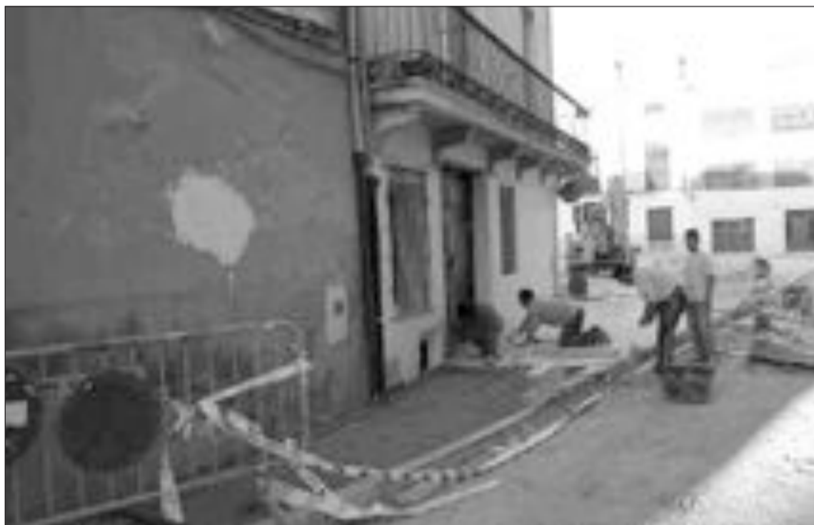
Obras de rehabilitación de la calle Luis Calpena, antiguamente calle Mayor
