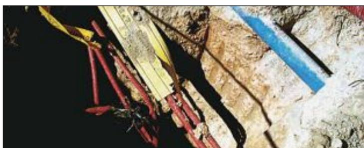
En la zanja abierta se aprecia que la distancia no corresponde con la del proyecto de urbanización, además de no tener las placas de protección
