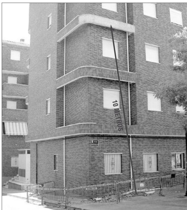
Desprendimiento de una cornisa en un edificio de la calle Jaime I
