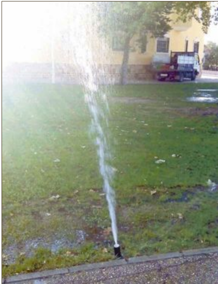
El destrozo de los aspersores provoca que el agua salga a chorros, en lugar de en forma de lluvia, deteriorando el césped e inundando los parques
