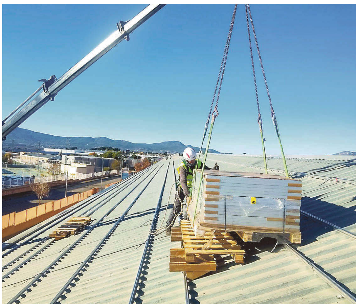
Instalación de placas solares en la cubierta de una nave industrial
