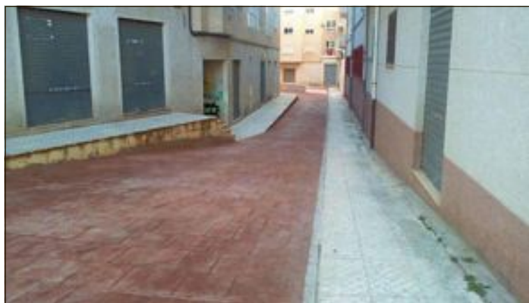
Se ha pavimentado el suelo con hormigón impreso y se ha arreglado el camino de piedra natural
