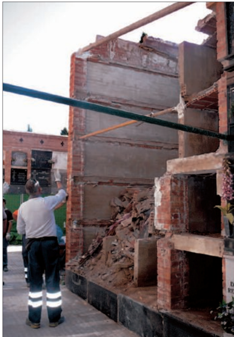
El desplome se ha producido en el recinto 2 afectando a tres columnas de cinco alturas
