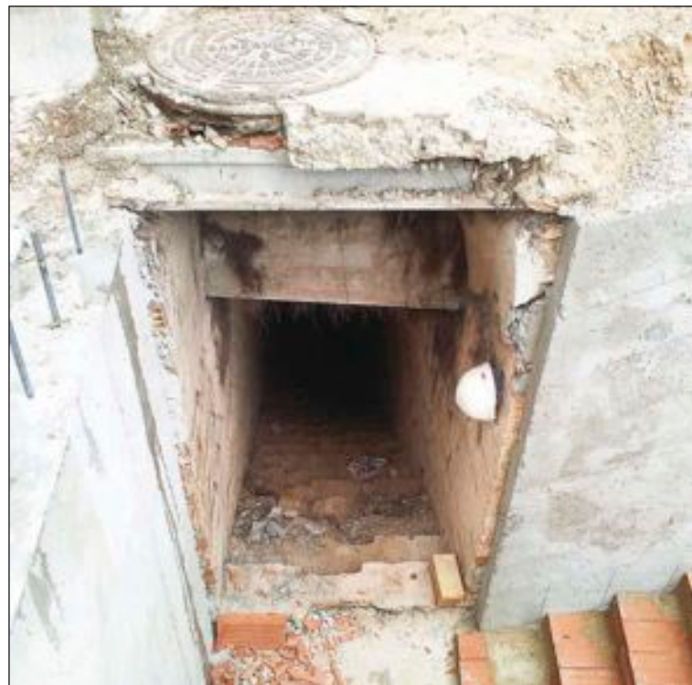
Para facilitar la entrada a uno de los refugios se ha hecho un corte transversal junto a la tapa de alcantarilla por la que se accedía anteriormente
