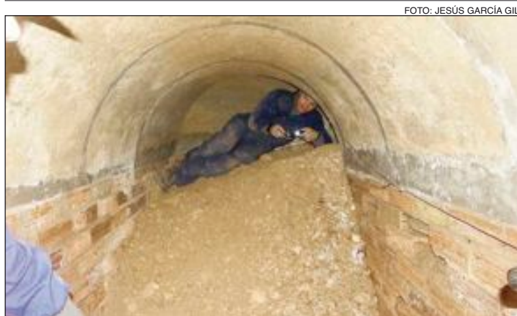
Los refugios están en buenas condiciones pero llenos de tierra, que hay que sacar al exterior para poder continuar con los trabajos de rehabilitación
