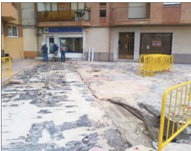
Obras de impermeabilización para evitar filtraciones en los garajes
