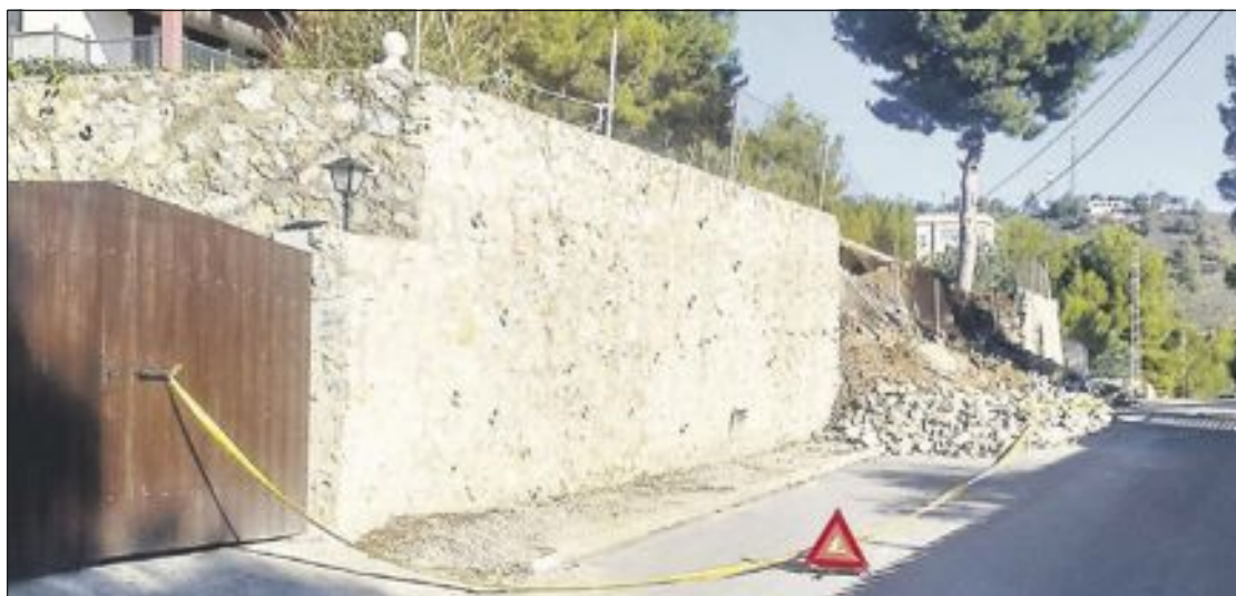
Al examinar los daños se determinó que era necesario derribar todo el muro porque los cimientos estaban afectados
