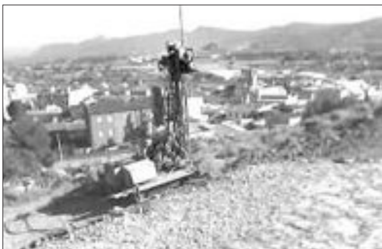
Realización de las catas técnicas del terreno
