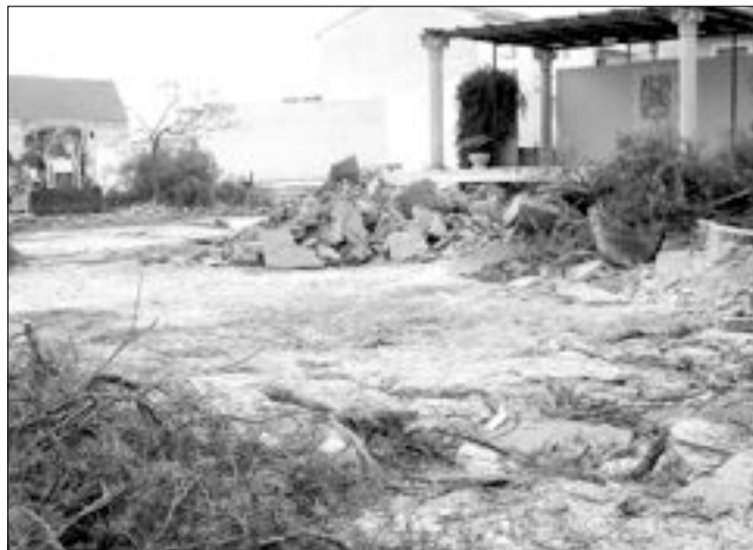
Actual aspecto de las obras en la Era del Teular
