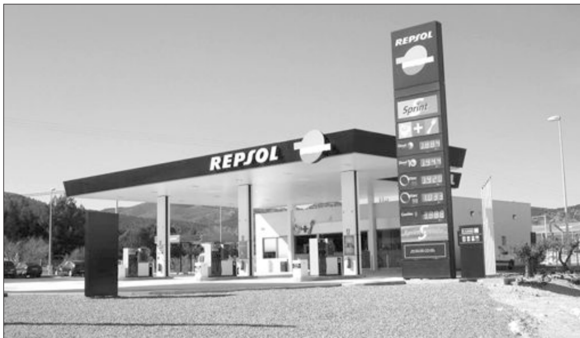
La nueva estaci n de servicio se encuentra en la carretera comarcal CV-815, junto a la rotonda de la A-7
