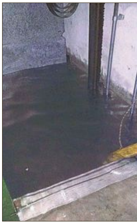
Izquierda, la rotura provocó en la tubería un gran chorro de agua; centro, el hueco del ascensor quedó totalmente inundado
