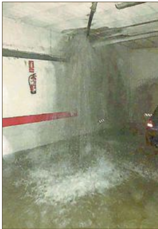
Izquierda, la rotura provocó en la tubería un gran chorro de agua; centro, el hueco del ascensor quedó totalmente inundado
