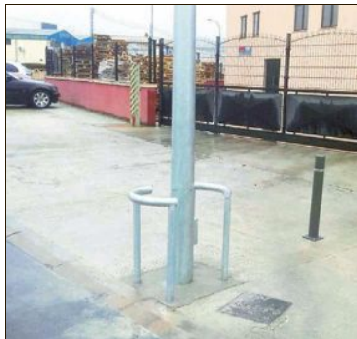
Se han repuesto diversas farolas y columnas de los polígonos y se han colocado protecciones metálicas
