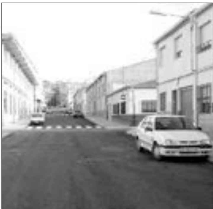
Aspecto de la calle Jovellanos tras las obras del colector
