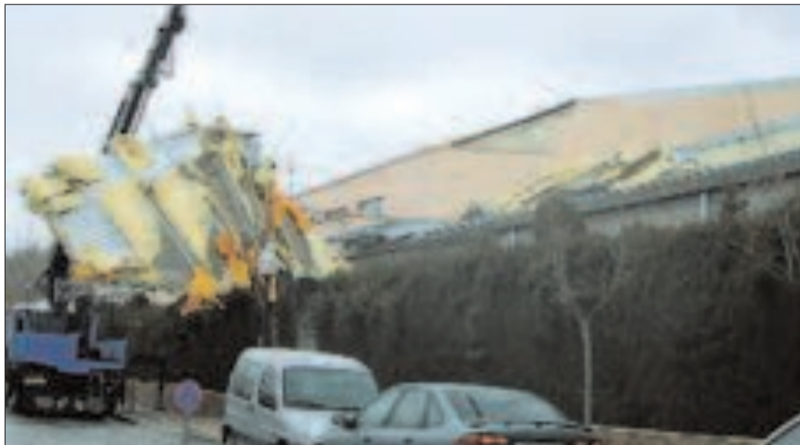
La brigada de obras municipal utilizó una grúa para levantar las chapas metálicas desprendidas del techo
