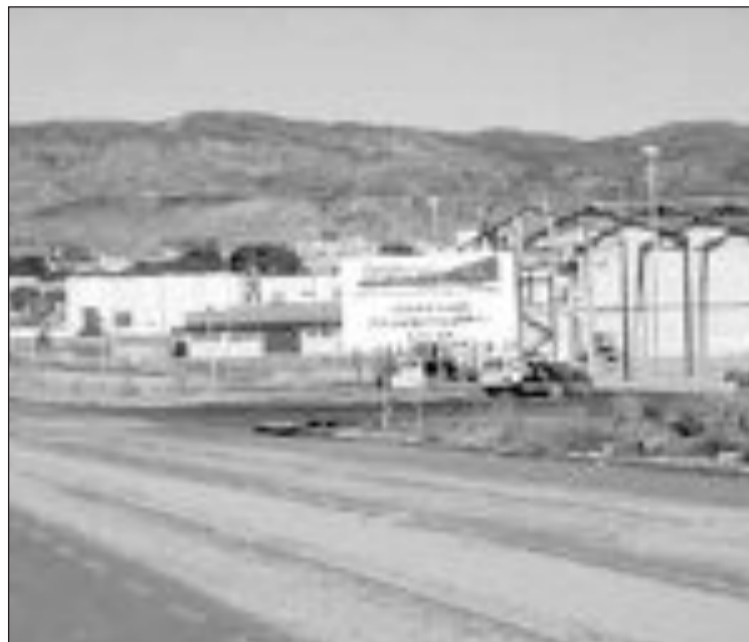
El tercer polígono industrial de Castalla cuenta con unas 27 parcelas
