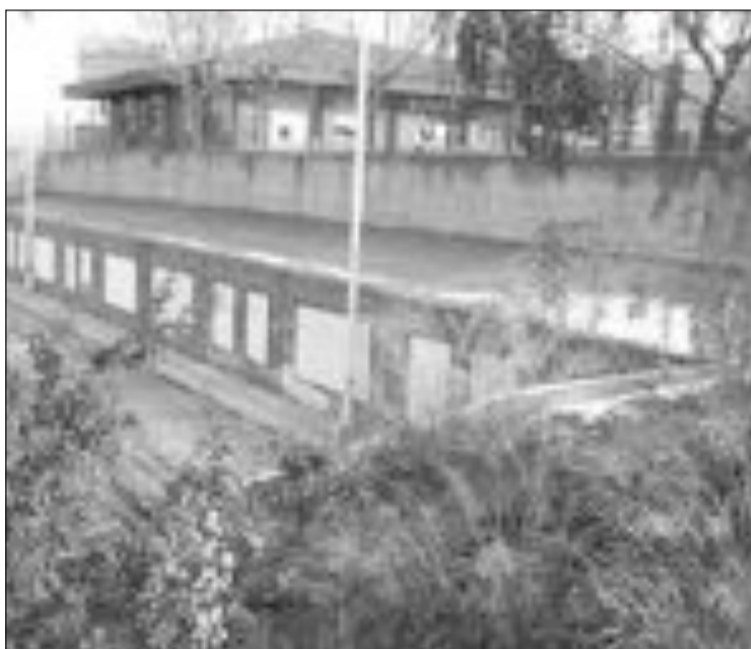
Reformas ejecutadas en el colegio Pla y Beltrán
