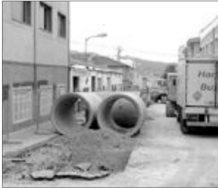
Instalación de un nuevo colector en la calle Jovellanos
