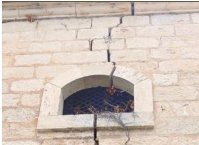
Aspecto de la grieta en la fachada del depósito de agua
