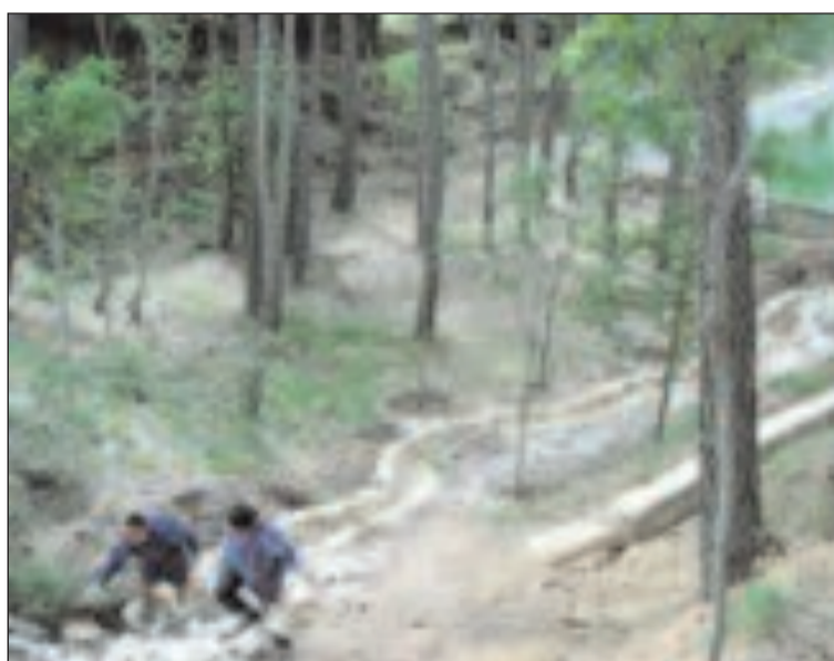
Los operarios construyen un riachuelo artificial para que el agua corra hasta la última balsa
