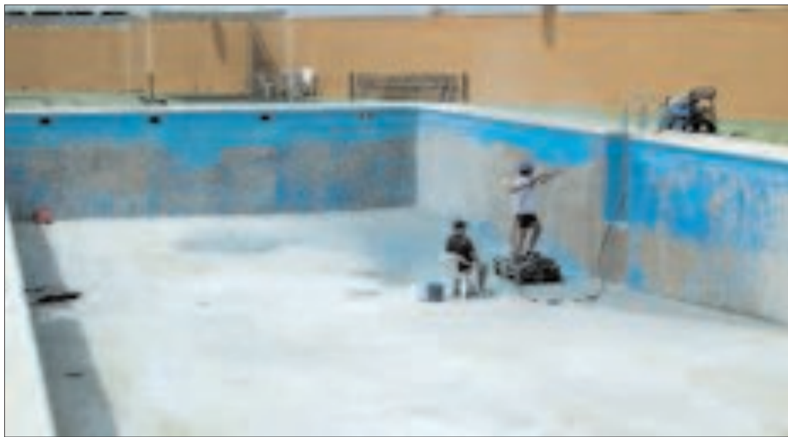
Actualmente se está procediendo a pintar la piscina del Climent, tras haber reparado las fisuras
