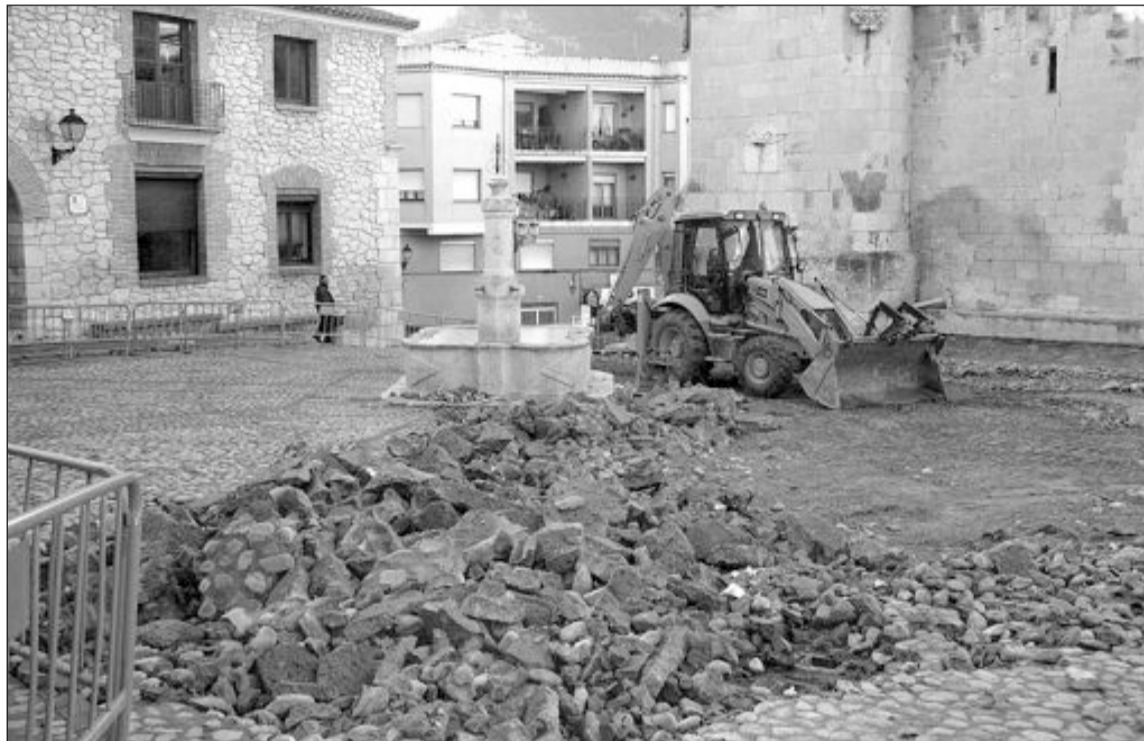
Las obras contemplan la sustitución de canalizaciones y pavimento, cableado de telefonía e iluminación
