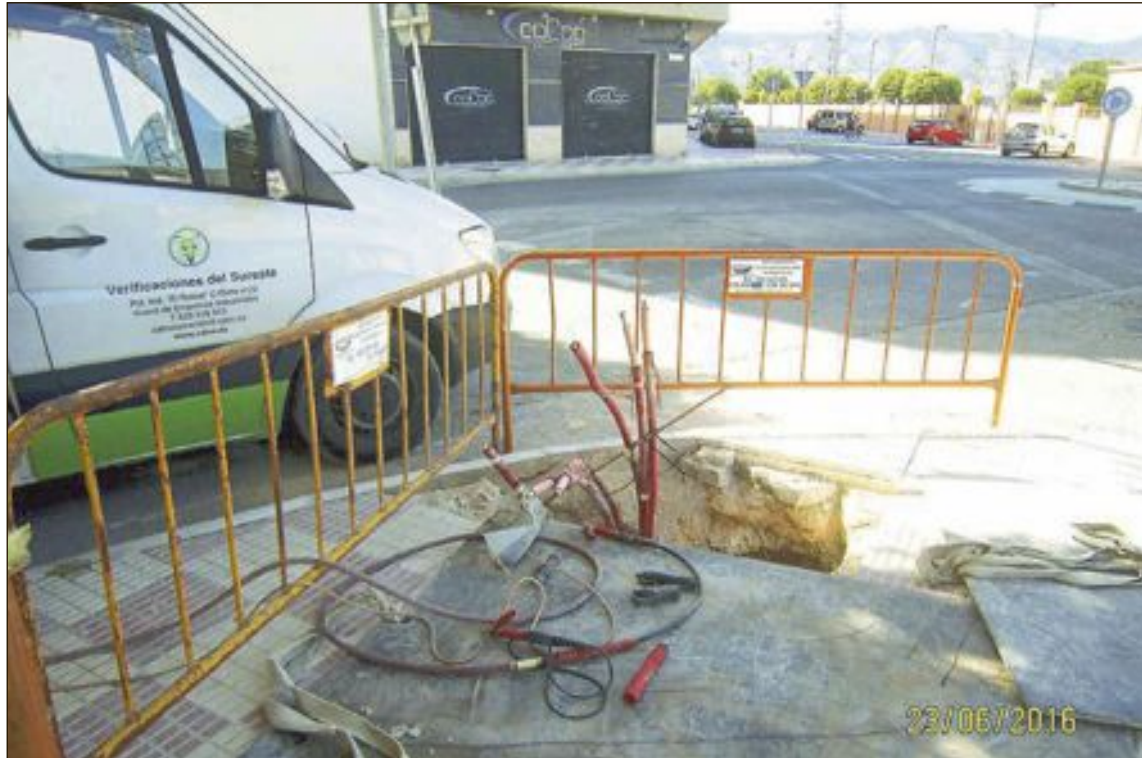
Punto de entronque con línea MT subterránea frente a polideportivo
