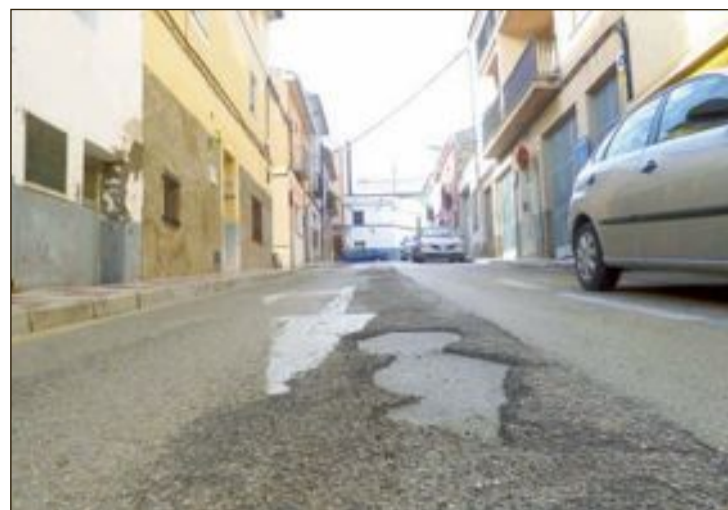
La calle Ancha presenta un asfalto muy deteriorado en algunos tramos
